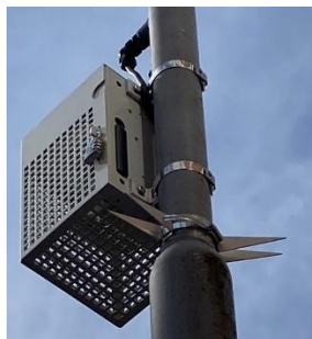
Beschermkast met mastconnector, mastbeugels en inklimbeveiliging
